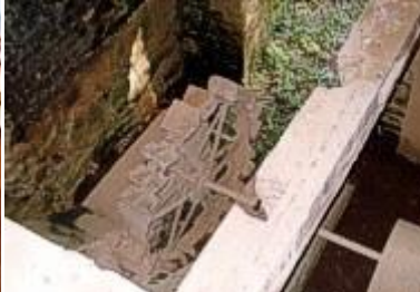
Casa das Máquinas
